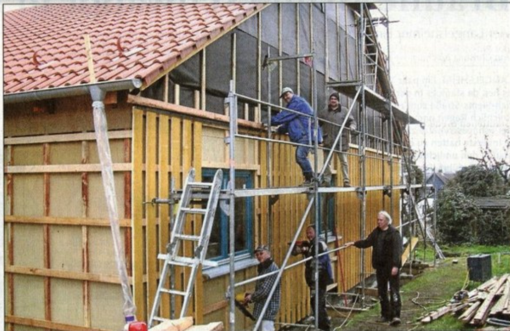
Das Dach ist fertig gedeckt, im nächsten Schritt verkleiden Handwerker und Helfer aus dem Elternkreis der Schule die Fassade des Schulbaus in Bredelem. Foto: Borchers
